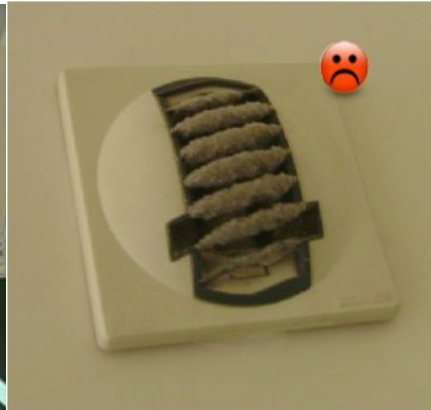
Illustration 70: Bouche d'extraction encrassée
